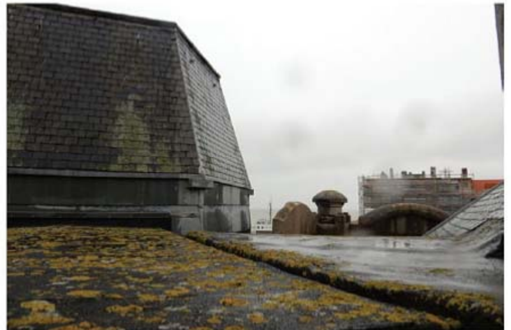
staat van het dak
