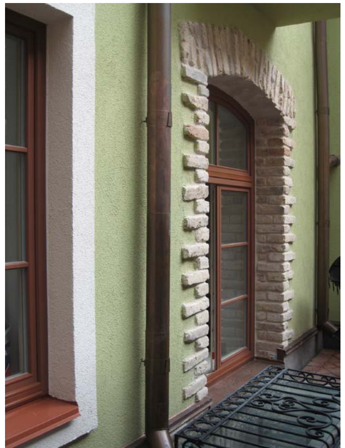
36. Patalpa Nr. 5, išorės fragmentas
