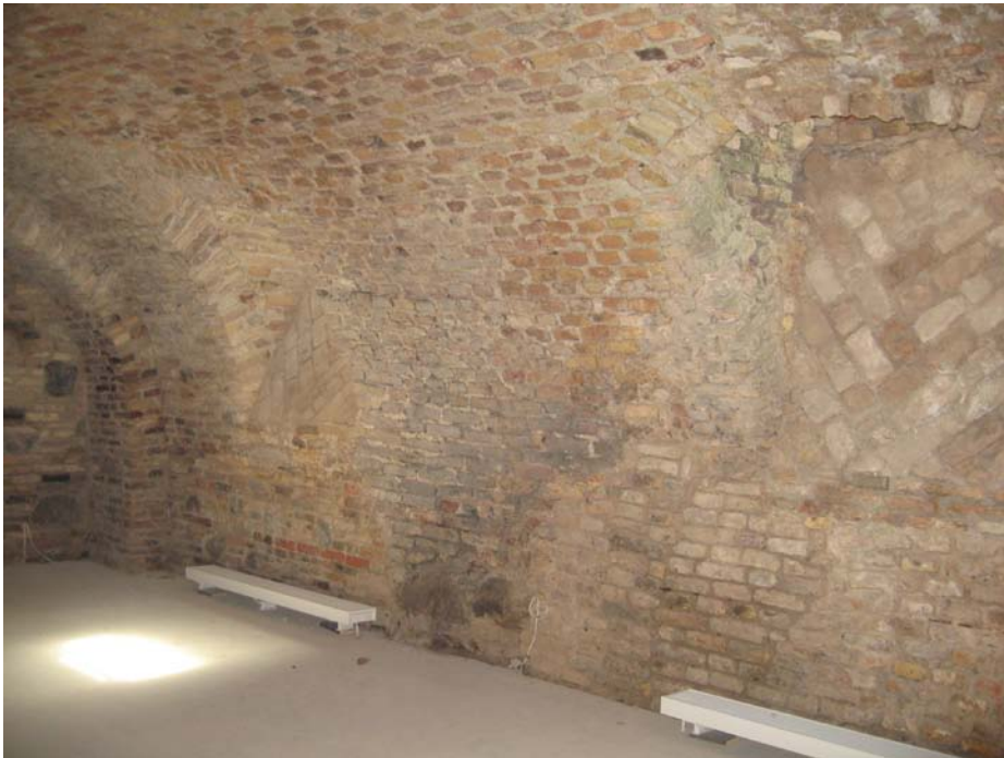
Nr.9. Rūsys, patalpa Nr. 20
