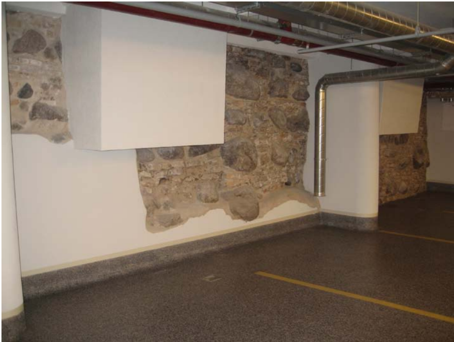
Nr.5. Garažo vaizdas, patalpa R1-1
