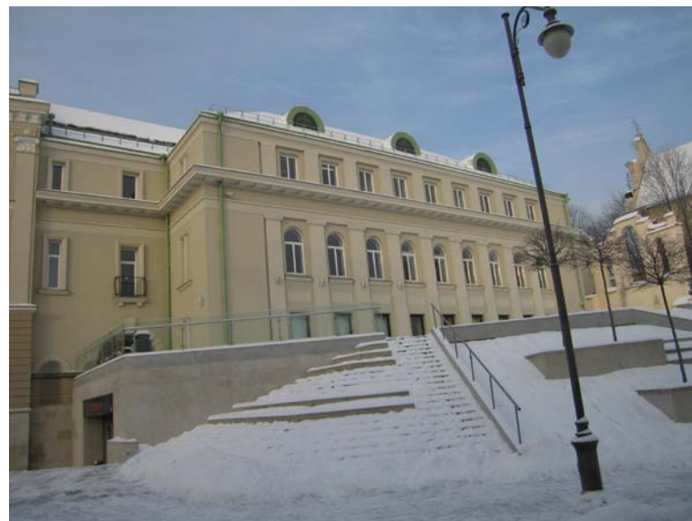
Rytinis fasadas iš Ž.Liauksmino g. pusės
