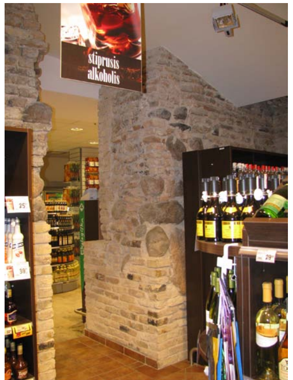
Plytų ir akmenų mūro atodanga pastato šiaurinės dalies pusrūsyje
