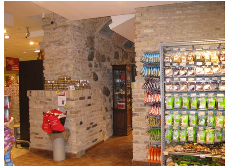
Plytų mūro atodanga pastato šiaurinės dalies pusrūsyje
