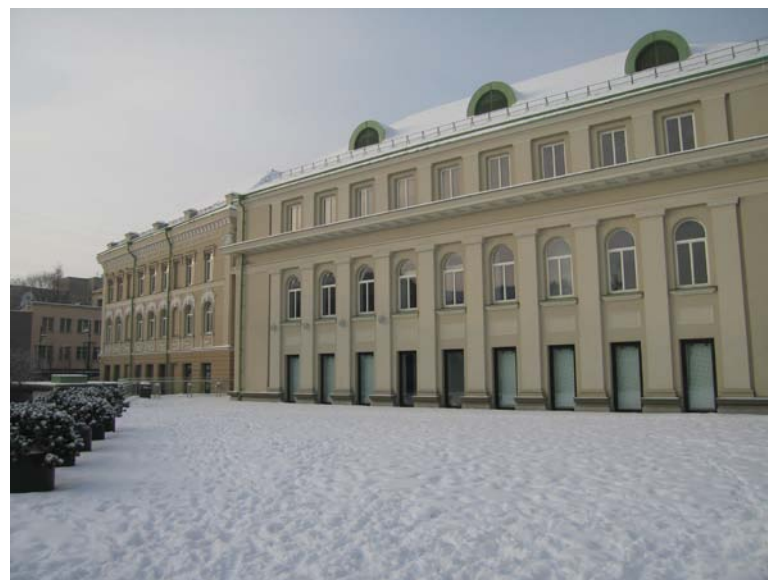
Rytinis fasadas iš Ž.Liauksmino g. pusės
