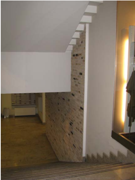
Plytų mūro atodanga pastato pietinės dalies rūsyje
