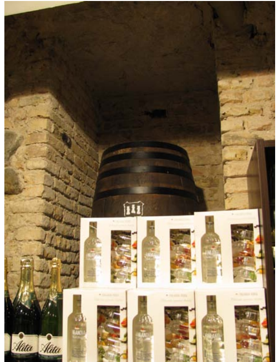
Plytų mūro atodanga pastato šiaurinės dalies pusrūsyje
