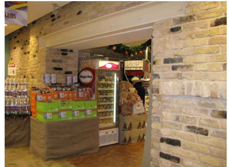
Plytų mūro atodanga pastato šiaurinės dalies pusrūsyje
