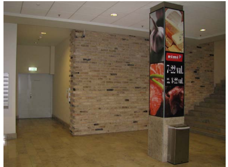
Plytų mūro atodanga pastato pietinės daļies rūsyje
