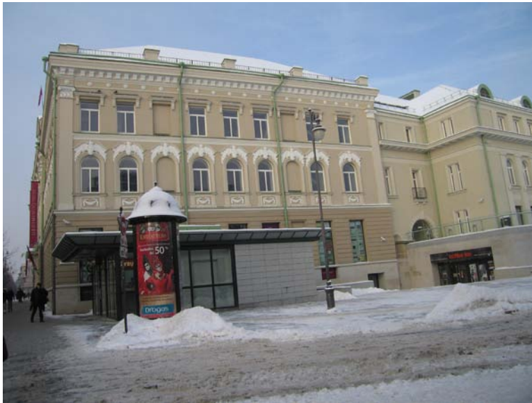
Rytinis fasadas iš Gedimino pr. pusės
