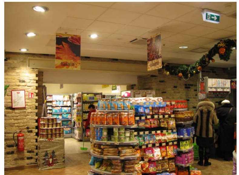
Plytų mūro atodanga pastato šiaurinės dalies pusrūsyje
