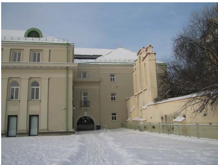
Rytinis fasadas iš Ž.Liauksmino g. pusės
