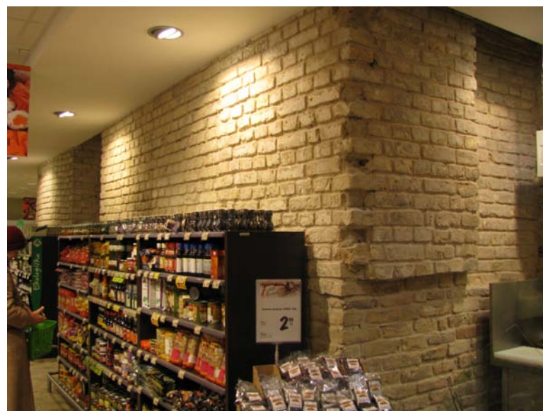
Plytų mūro atodanga pastato šiaurinės dalies pusrūsyje
