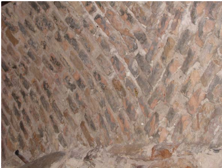
Plytų mūro atodanga pastato šiaurinės dalies pusrūsyje
