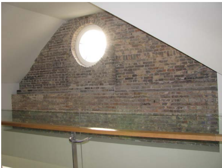
Plytų mūro atodanga pastato 4-tame a.
