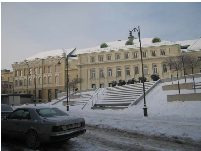
Rytinis fasadas iš Ž.Liauksmino g. pusės
