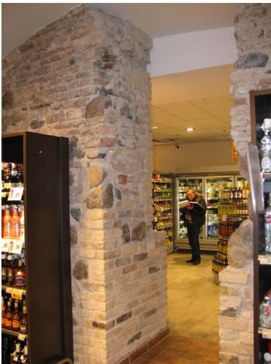
Plytų ir akmenų mūro atodanga pastato šiaurinės dalies pusrūsyje
