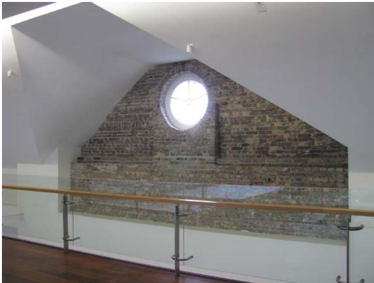
Plytų mūro atodanga pastato pietinės dalies 4-ame aukšte
