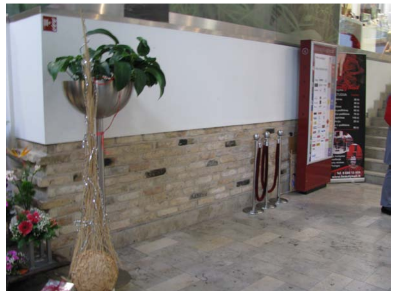
Plytų mūro atodanga pastato pietinės dalies 1-ame aukšte
