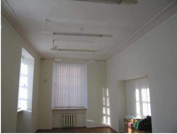
1-mo aukšto patalpa 5-1
