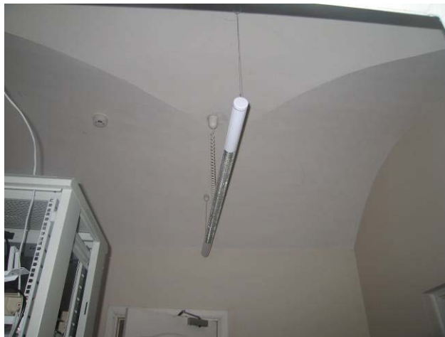
1-mo aukšto patalpa 6-8
