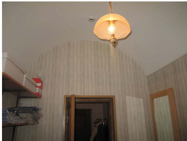
1-mo aukšto patalpa 8-4
