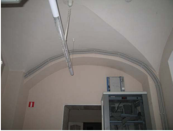
1-mo aukšto patalpa 6-8
