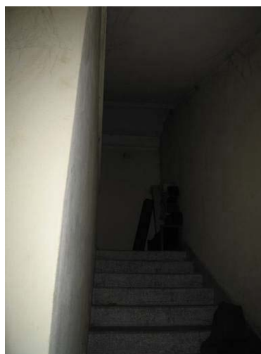
Rūšio patalpa R1-1
