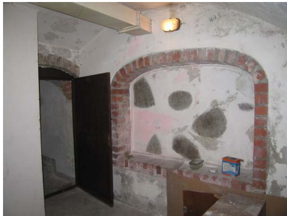
Rūsio patalpa R1-4
