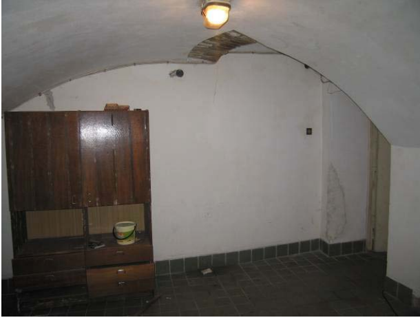
Rūsio patalpa R-6
