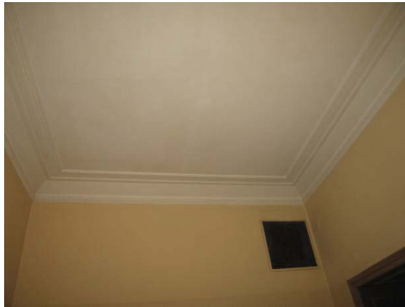
1-mo aukšto patalpa 1-3
