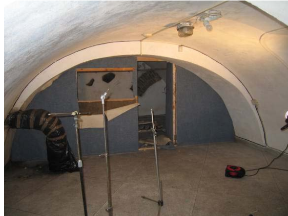
Rūsio patalpa R-7
