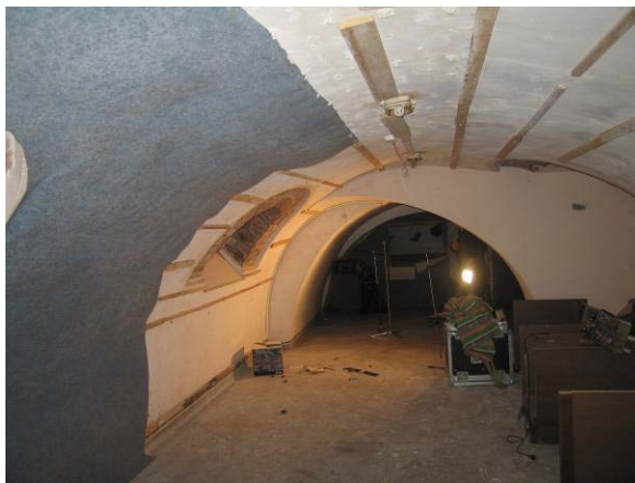
Rūsio patalpa R-7
