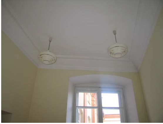
2-ro aukšto patalpa 2-6
