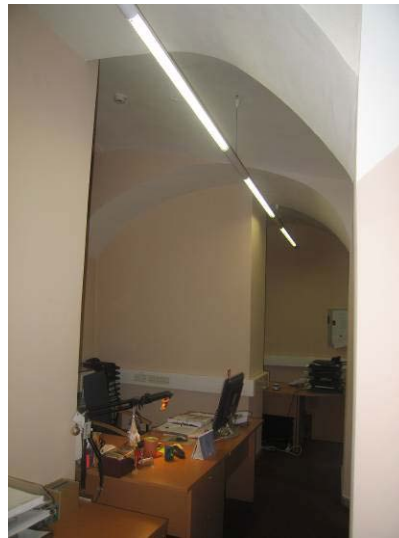
1-mo aukšto patalpa 6-7
