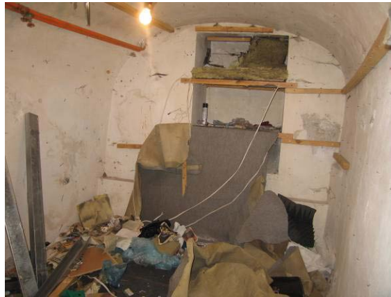
Rūsio patalpa R-11
