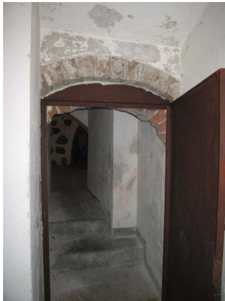
Praėjimas tarp rūšio patalpų R1-4 ir R1-7
