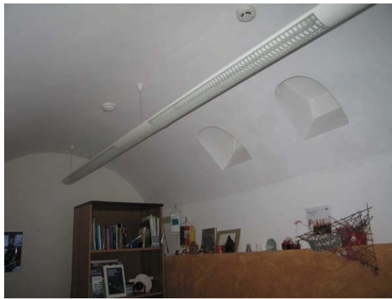
1-mo aukšto patalpa 8-10
