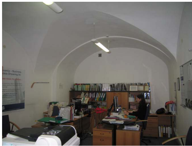
1-mo aukšto patalpa 8-8
