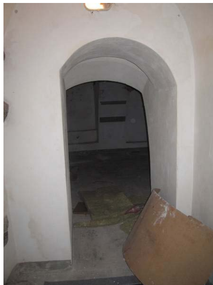
Praėjimas tarp rūšio patalpų R1-8 ir R-9
