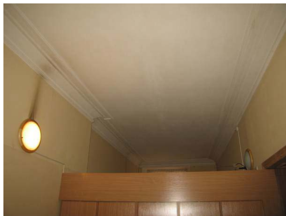
1-mo aukšto patalpa 1-3
