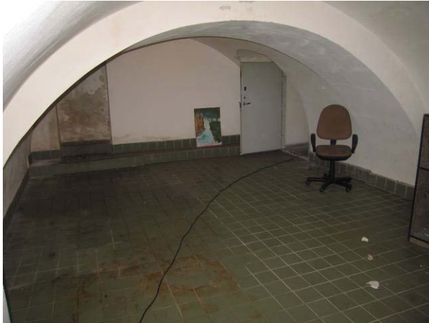
Rūsio patalpa R-6
