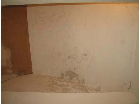
Rūsio patalpa R1-6
