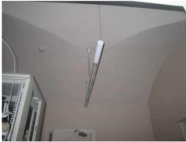
1-mo aukšto patalpa 6-8
