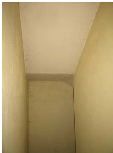
Rūšio patalpa R1-1
