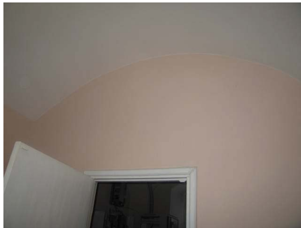
1-mo aukšto patalpa 6-9
