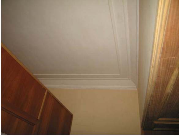
1-mo aukšto patalpa 1-3
