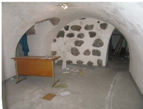
Rūsio patalpa R1-7
