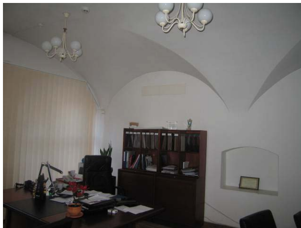
1-mo aukšto patalpa 8-2
