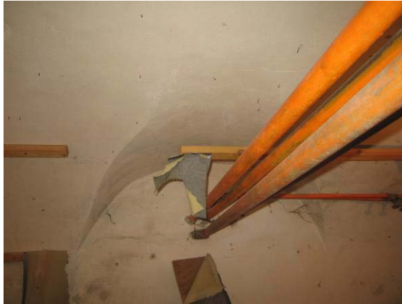
Rūsio patalpa R-11
