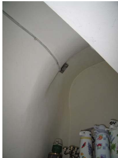
1-mo aukšto patalpa 1-5
