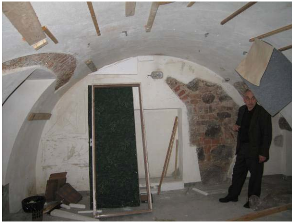
Rūsio patalpa R-9
