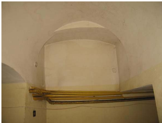
Rūsio patalpa R-3
