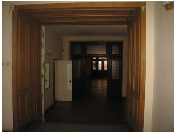
Vaizdas iš 1-mo aukšto patalpos 1-11 į patalpą 1-2
