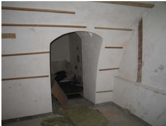
Praėjimas tarp rūšio patalpų R-9 ir R1-8
