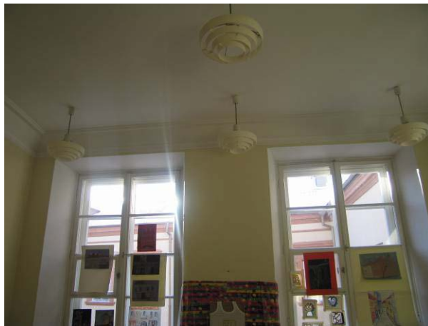
2-ro aukšto patalpa 2-5
