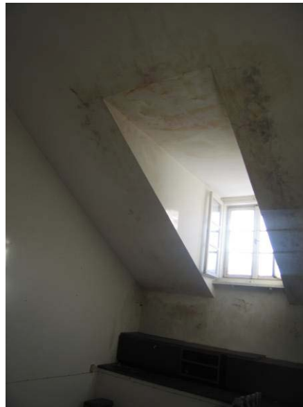
Palėpės patalpa a-5
