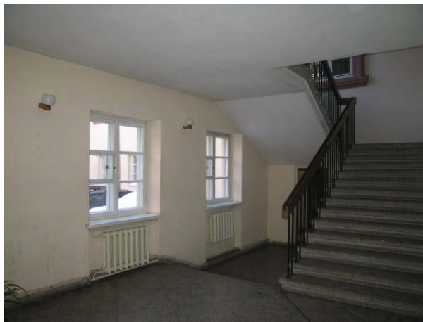
1-mo aukšto patalpa 1-12 (laiptinė į 2-ą a., į patalpą a-4)
