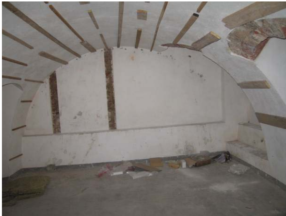
Rūsio patalpa R-9
