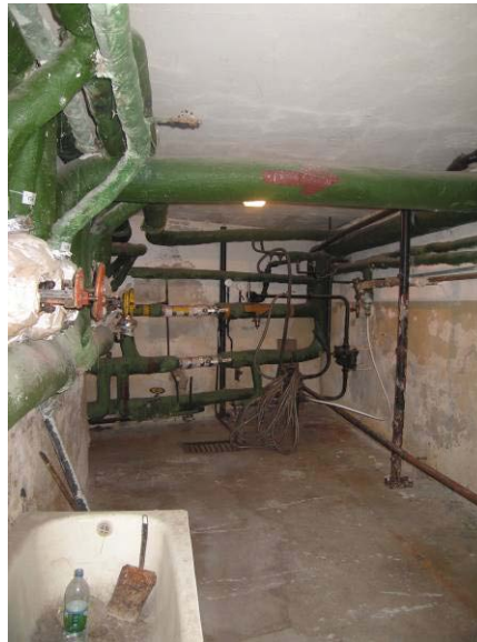
Rūsio patalpa R2-1
