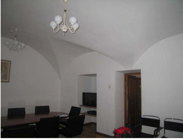
1-mo aukšto patalpa 8-2
