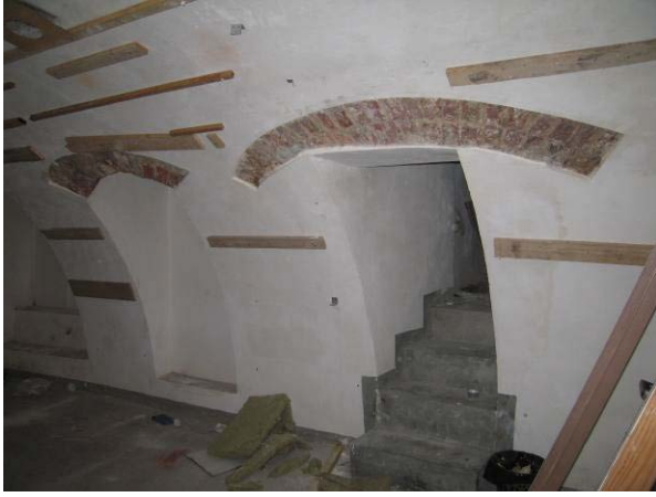
Rūsio patalpa R-9
