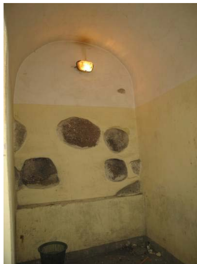
Rūsio patalpa R1-3
