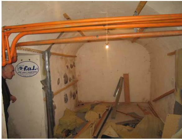
Rūsio patalpa R-11
