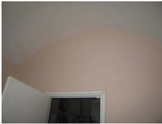
1-mo aukšto patalpa 6-9
