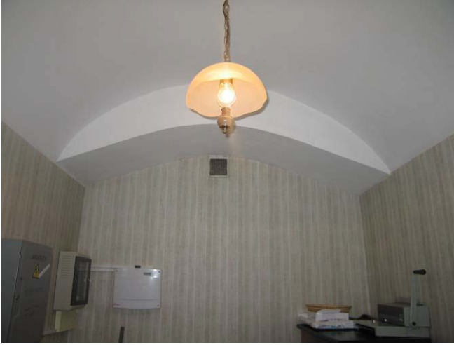
1-mo aukšto patalpa 8-4
