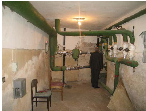
Rūsio patalpa R2-1
