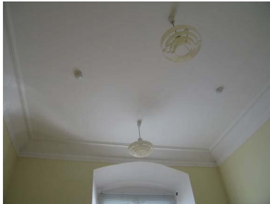
2-ro aukšto patalpa 2-19
