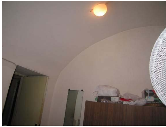
1-mo aukšto patalpa 1-4
