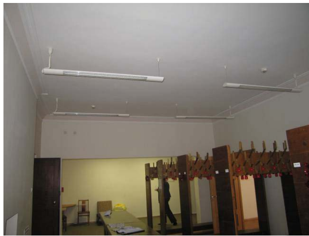
1-mo aukšto patalpa 5-1
