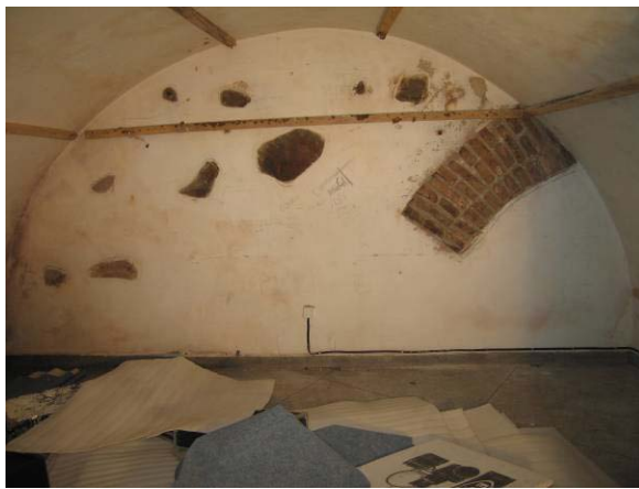
Rūsio patalpa R-7
