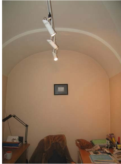
1-mo aukšto patalpa 7- 3
