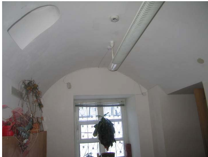
1-mo aukšto patalpa 8-10
