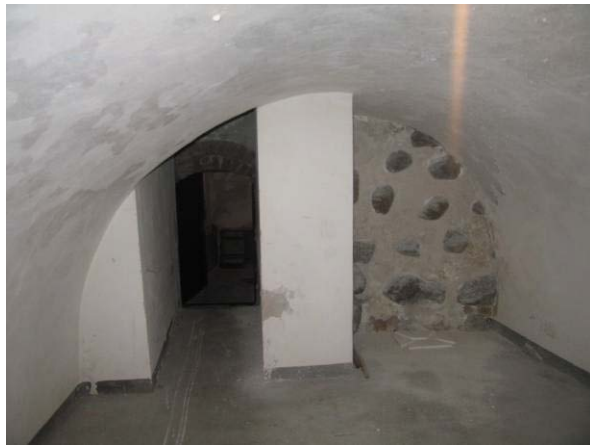
Rūsio patalpa R1-7
