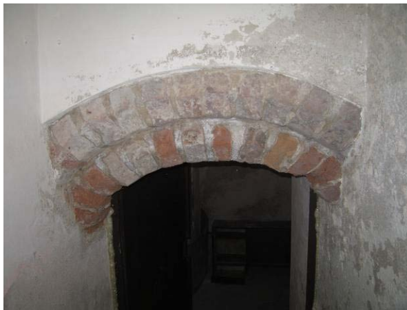
Praėjimas tarp rūšio patalpų R1-7 ir R1-4
