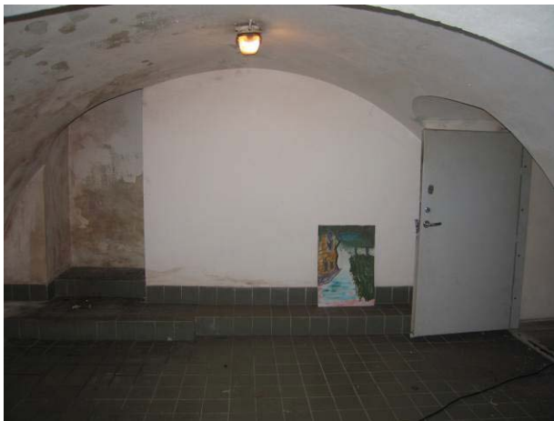
Rūsio patalpa R-6
