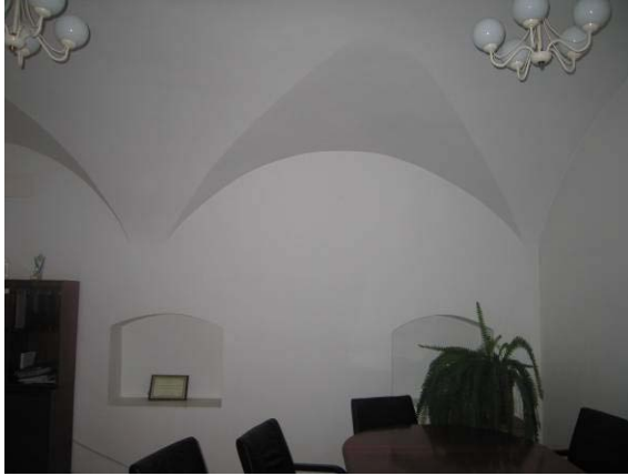
1-mo aukšto patalpa 8-2
