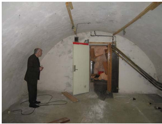
Rūsio patalpa R-10
