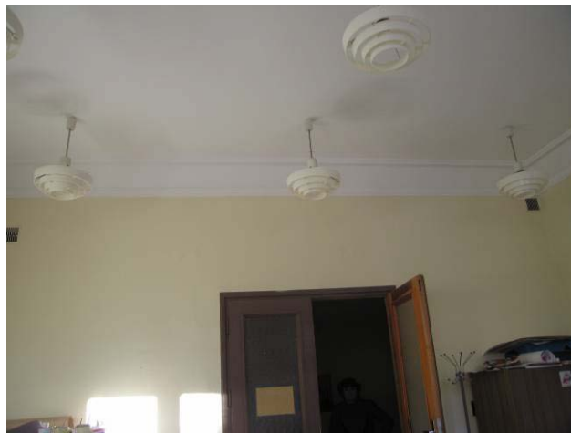
2-ro aukšto patalpa 2-5
