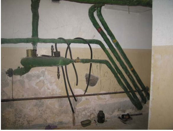
Rūsio patalpa R2-1
