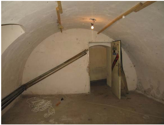
Rūsio patalpa R-10
