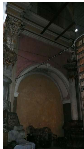
31. Patalpa Nr. I-1
