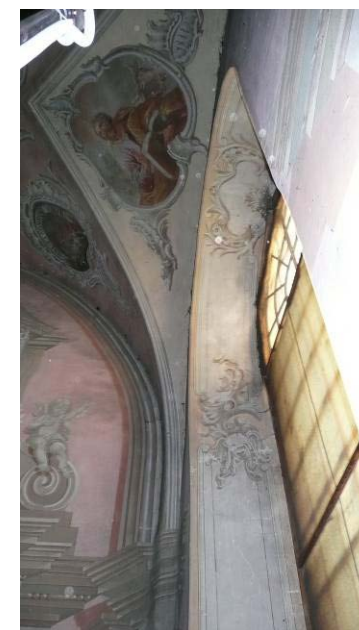
40. Patalpa Nr. I-1
