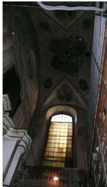
24. Patalpa Nr. I-1
