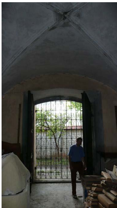
47. Patalpa Nr. I-2
