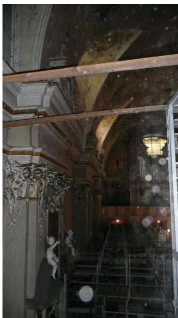
41. Patalpa Nr. I-1
