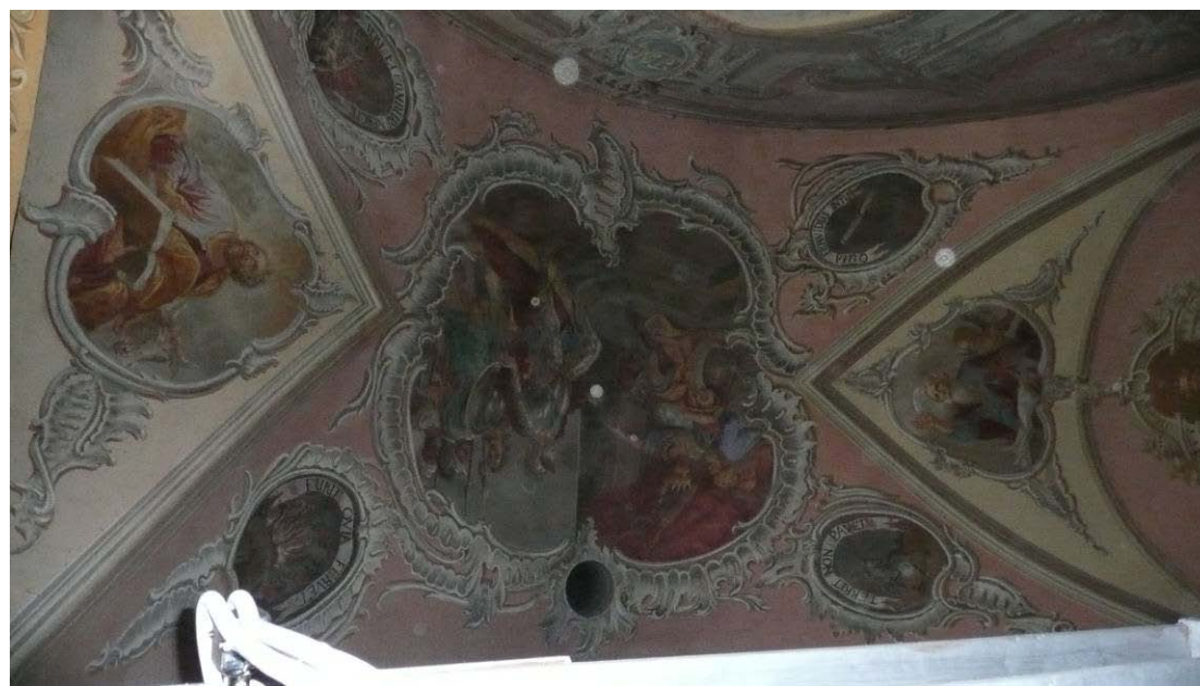
39. Patalpa Nr. I-1
