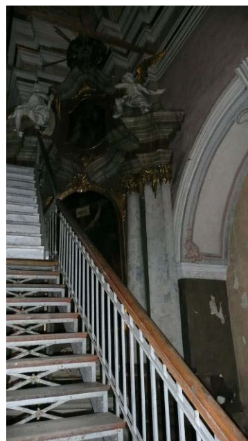
34. Patalpa Nr. I-1
