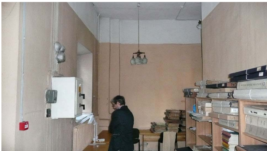
11. Patalpa Nr. III-1
