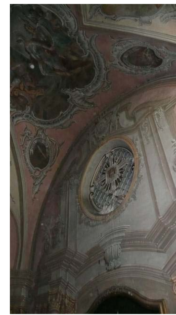
37. Patalpa Nr. I-1
