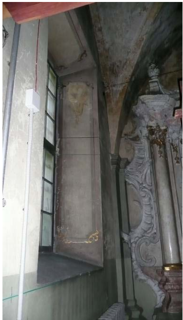
4. Patalpa Nr. IV -1
