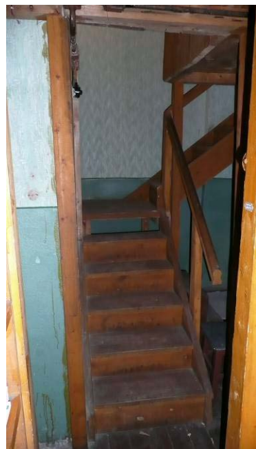
14. Patalpa Nr. III-1
