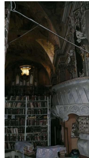
27. Patalpa Nr. I-1
