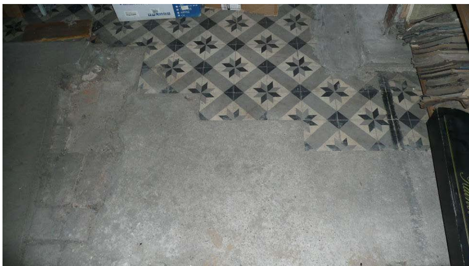
28. Patalpa Nr. I-1
