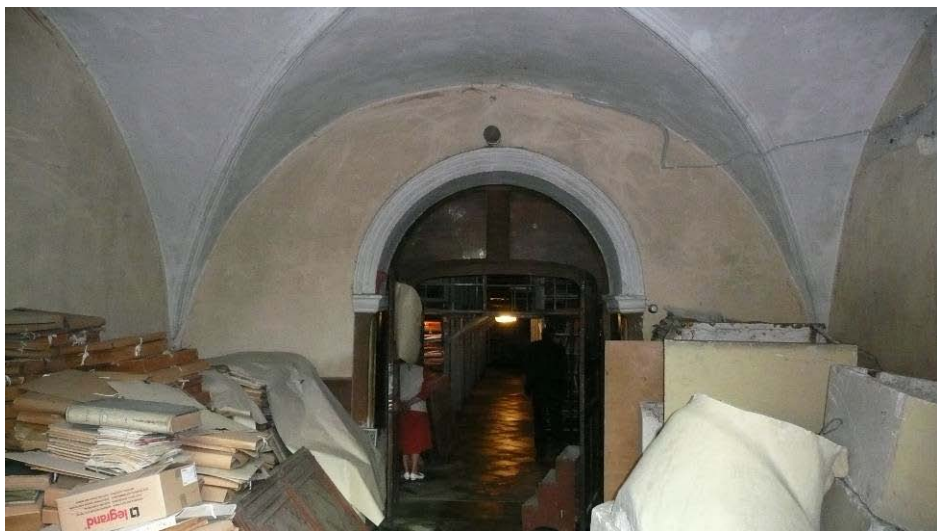
45. Patalpa Nr. I-2
