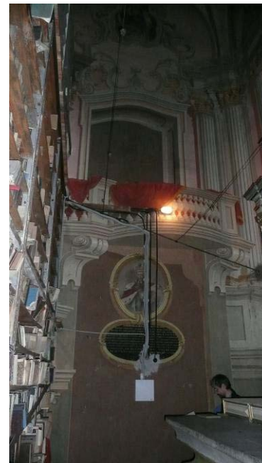
26. Patalpa Nr. I-1
