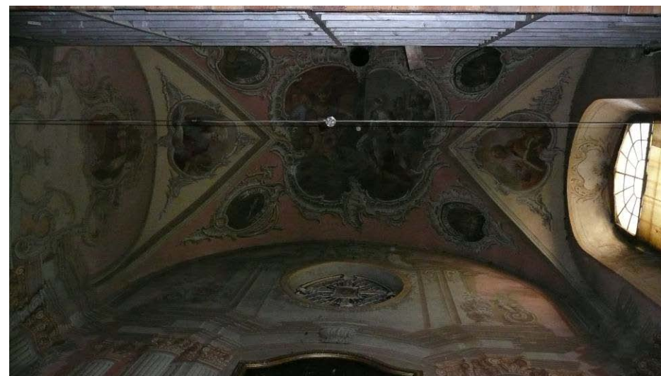
29. Patalpa Nr. I-1
