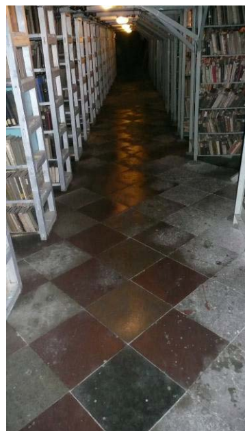
42. Patalpa Nr. I-1
