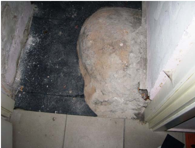
Akmens mūro fragmentas praējime iš patalpos R4-4 į patalpą R4-3
