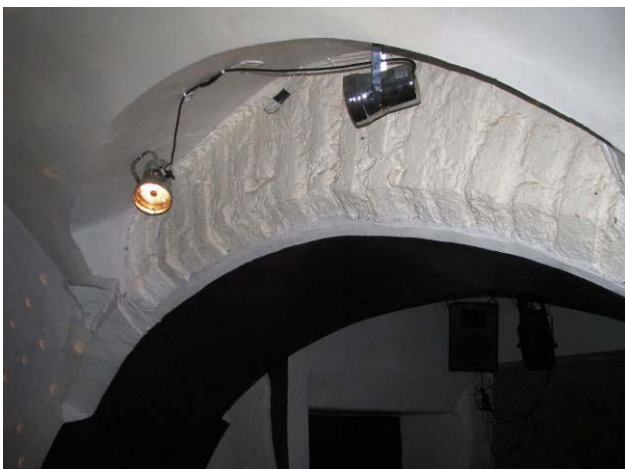
Plytų mūro fragmentas virš arkos patalpoje R4-4
