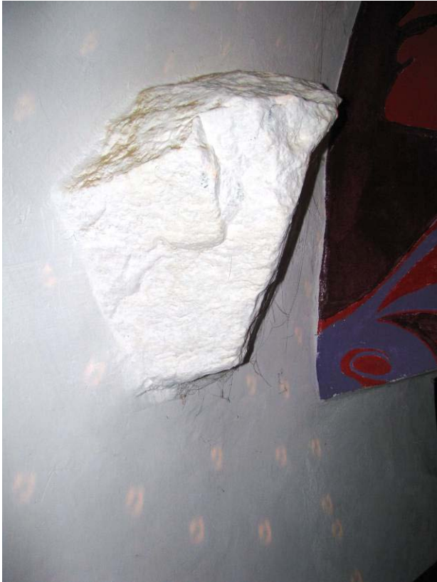
Akmens mūro fragmentas patalpoje R4-4
