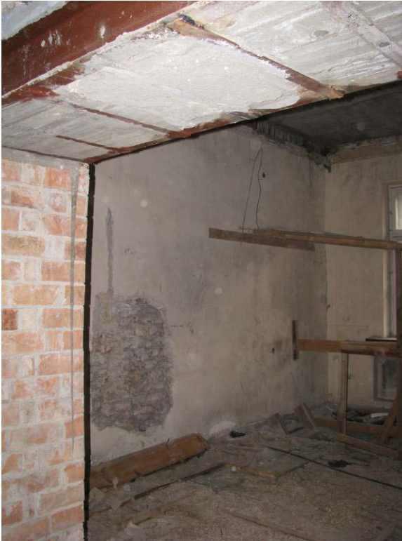
Sąramos fragmentas virš angos į patalpas 46-17 ir 46-18
