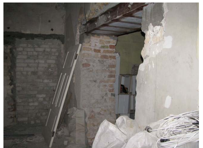
Vaizdas patalpoje 46-7, sėramos fragmentas virš angos į patalpą 46-1
