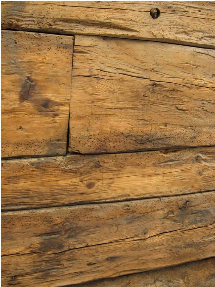
Medžio graužikų pažeista balaninė medienos dalis
